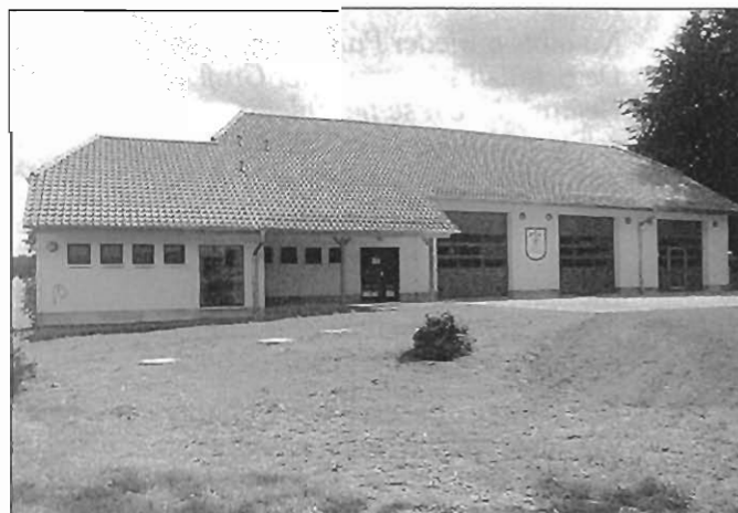
Das neuerrichtete Feuerwehrdepot in Spitzkunnersdorf
