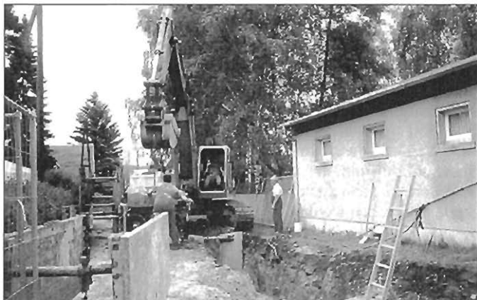
Kanalbaumaßnahme am Kastanienweg
