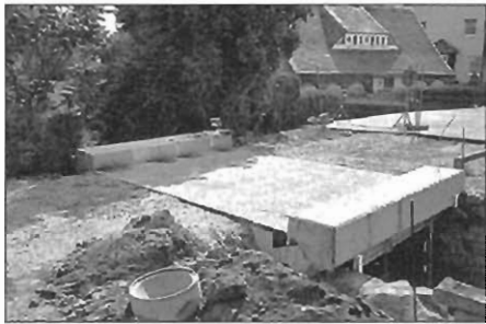
Brücke Mittelstraße im Rohbau – August 2003
