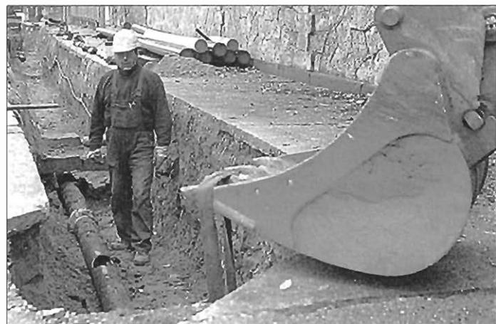
durch erhöhten Schwerlastverkehr als auch im Zusammenhang mit gefrierendem Erdreich. Die Gasversorgungsunternehmen verstärkten seitdem ihre Bemühungen um eine Erneuerung der Graugussnetze erheblich.
