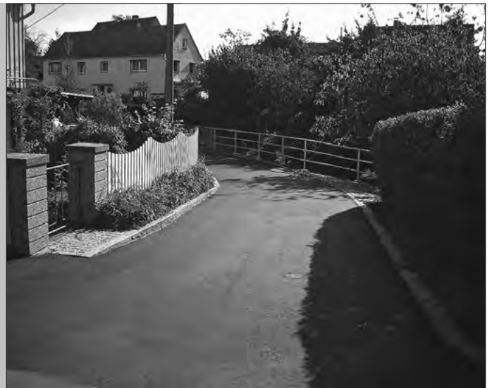
... Straßendeckenerneuerung Kastanienweg in Spitzkunnersdorf
