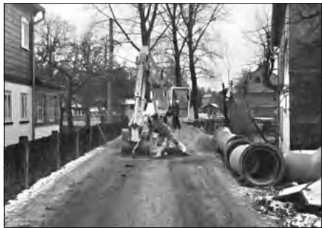
Verlegung des Hauptsammlers im Jahr 1994
