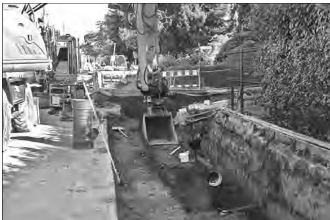
Baustelle Hauptstraße in Leutersdorf
