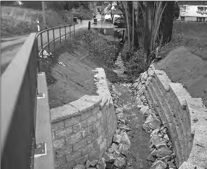
Ersatzneubau Brücke Melzers Teich OT Spitzkunnersdorf
