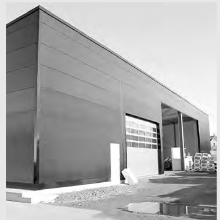
Lagerhalle, Fa. Werder, Geschwister-Scholl-Straße
