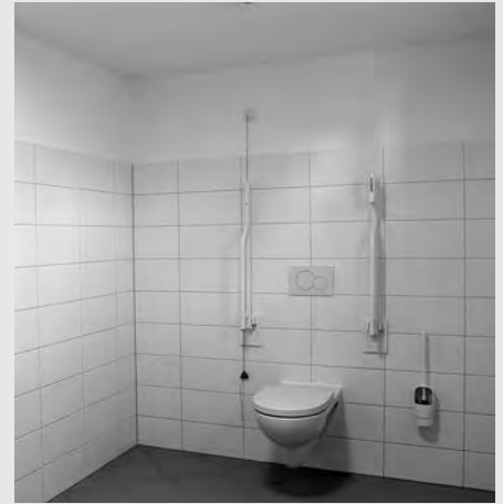
1. BA Gemeindezentrum Spitzkunnersdorf: Einbau Behinderten-WC, Erneuerung Heizung und Elt
