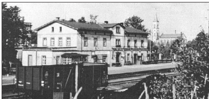
Reste der Bahnsteigüberdachung, die Kurbelwerkumbauung und das Sperrehäuschen sind am 25.9.1960 noch zu erkennen. – Foto: Waszner
