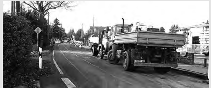
Verlegung von Breitbandkabel in Leutersdorf
