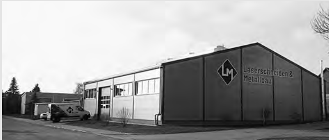
Büro- und Hallenbau Firma Speerschneider
