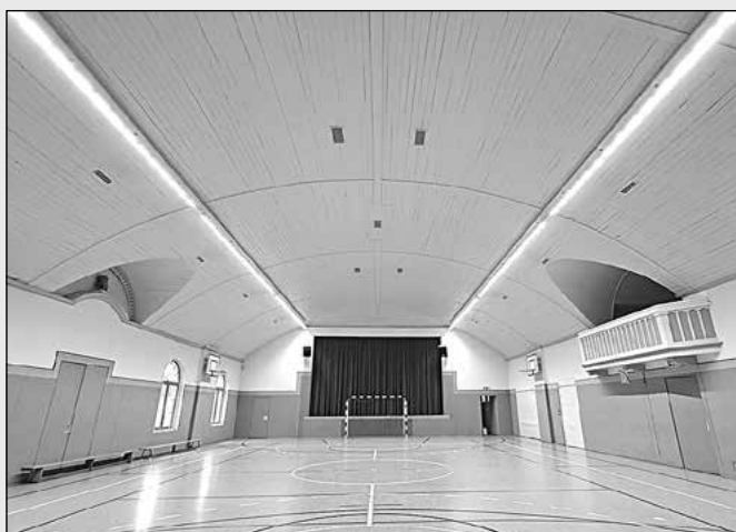
Erneuerung Beleuchtung Turnhalle F.-L.-Jahn-Str.
