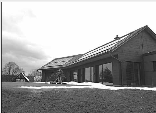
Einfamilienhaus Aloys-Scholze-Straße 14a
