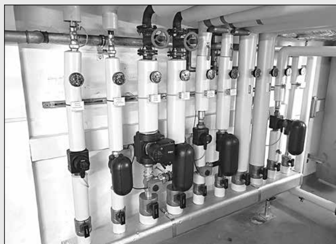
Erneuerung Heizung Turnhalle F.-L.-Jahn-Str.
