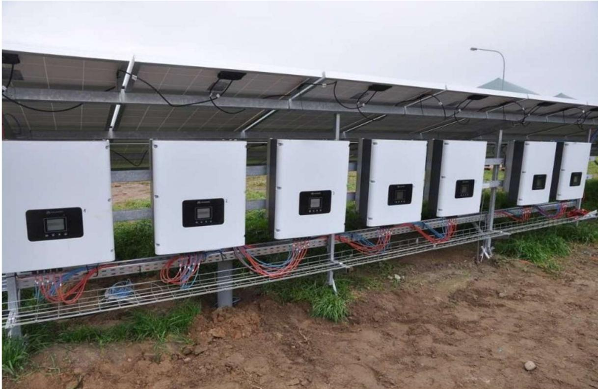
Abb.2 Wechselrichter unterhalb der Modulreihen angebracht
